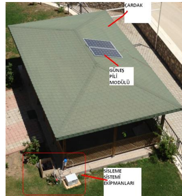
Şekil 1. Çardak bölgesi sisleme sistemi (In arbor misting system)
