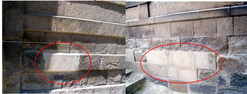
Şekil 4. Yenilenmiş taşların görünümü. (The view of restored stones)
