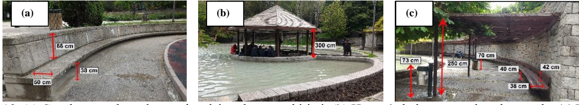
Şekil 13. (a) Çocuk oyun alanında yer alan dairesel oturma birimi; (b) Havuzda bulunan üstü kapalı pergola; (c) Havuz karşısında yer alan üstü açık dairesel pergola (Orijinal, 2017)
