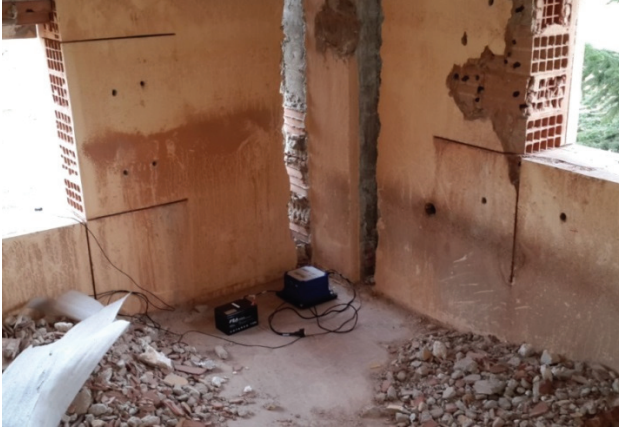
Şekil 10. Zemin katında bölme duvarları etkisizleştirilmiş binadan titreşim kayıtlarının alınması
