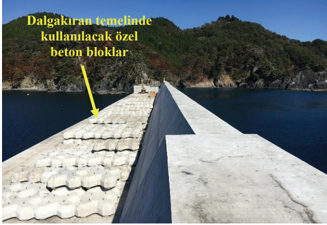
Fotoğraf 3. Yeniden İnşa Edilen Ofunato Dalgakıranı (Tarih: Ekim, 2016)
