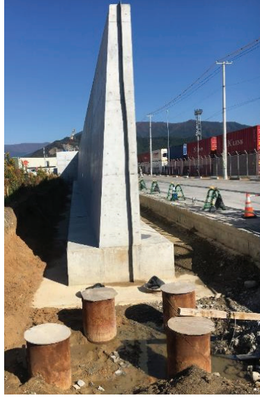
Fotoğraf 4. Ofunato Limanı Kıyı Duvarları Yapımı (Tarih: Ekim, 2016)
