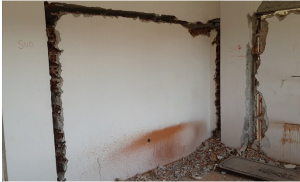
Şekil 8. Duvar ayırma sonrasında yapı içinden görünüş
