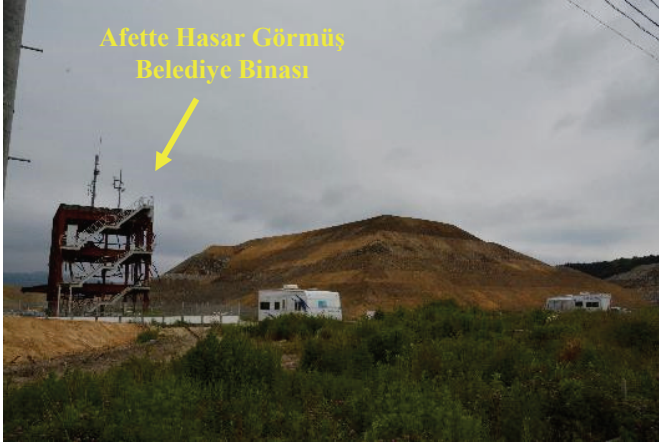
Fotoğraf 11. Kot Yükseltme Çalışmaları, Minamisanriku (Tarih: Haziran, 2016)
