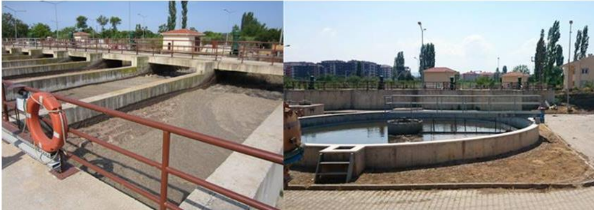
Şekil 2. Kepez Atık Su Arıtma Tesisleri
