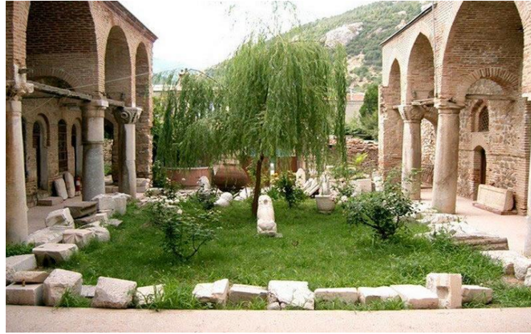
Şekil 9. Taş Medresenin iç avlusunun taş kapıya doğru görünüşü (Restitüsyon Rapor, 2009)
