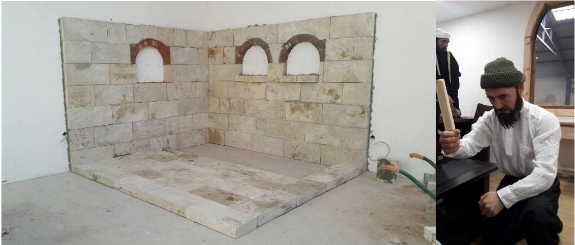
Şekil 24. Ana eyvanın uygulamasından görünüş
