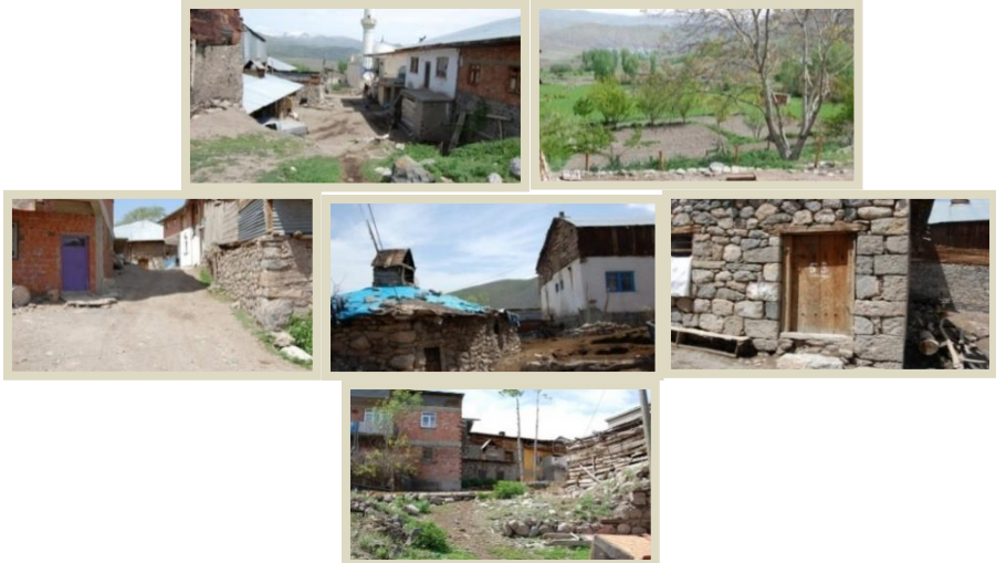
Şekil 27. Köy içi sokaklar oldukça bakımsız, ancak topoğrafik yapı görsel değeri artırmaktadır.
