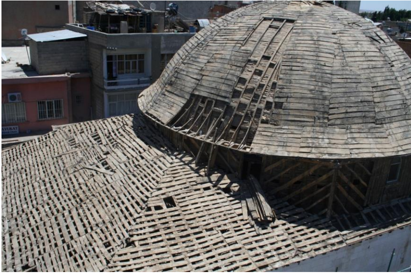
Foto. 3 Kab Camisi 2007 Restorasyonunda Üst Örtünün Onarımı (Şanlıurfa Koruma Kurulu'ndan)
