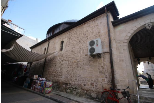
Foto. 12 Kab Camisi Doğu Cephesi
