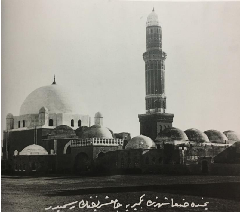
San'a Bekiriye Camii 120
