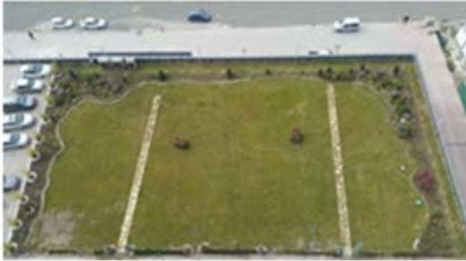
Şekil 11. AP Green Tower çatı bahçesi.
