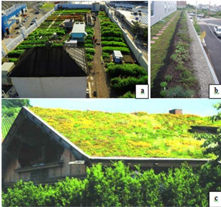
Şekil 1 (a,b,c). Yoğun (Entansif) Çatı Bahçesi, Yarı- Yoğun Çatı Bahçesi, Yayılıcı Çatı Bahçesi (Anonim, 2016a).
