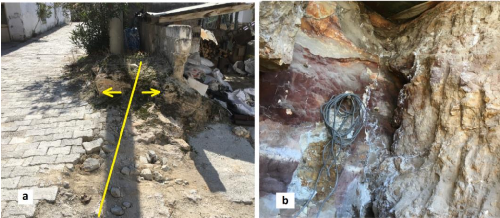
Şekil 7, a: PTT binası güneyindeki çatlağın mostra görünümü (doğuya bakış), b: Şekil 7 a'nın 15-20 m kuzeyinde çatlağın konumu (güneye bakış)
