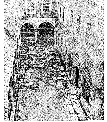
Resim 3. Cariyeler taşlığı ve onarım sırasında döşeme altında ortaya çıkan eski bina kalıntıları.
