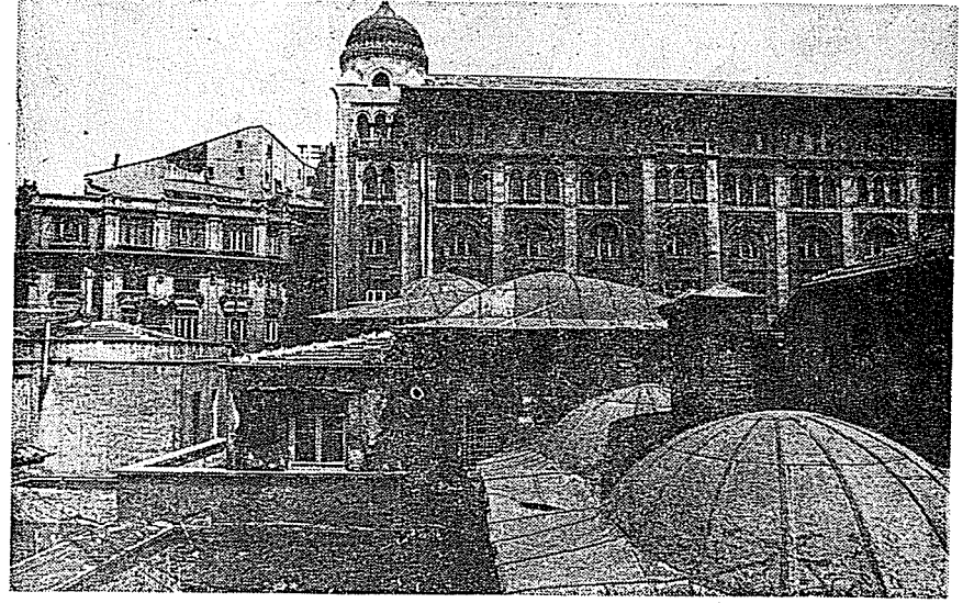
Resim 12. Kütüphane'nin güney cephesi ve arka planda 4. Vakıf Hanı.
