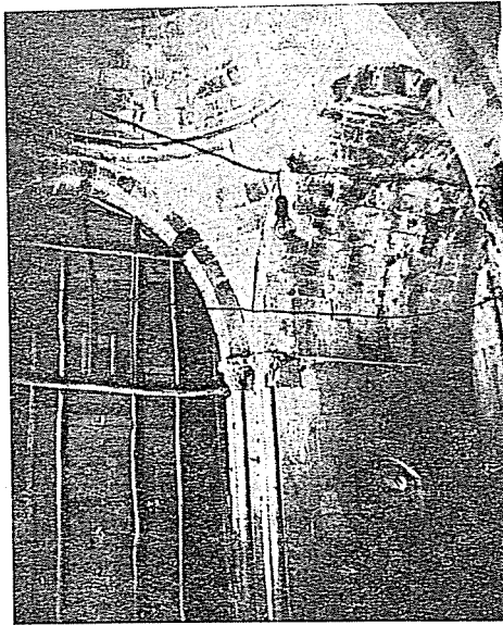
Marufiye medresesi, üç eyvanlı bölümde geçişler.
