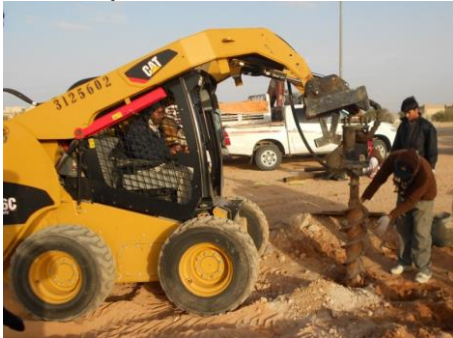
Şekil 2. Nivelman noktası çukurunun iş makinesi ile açılması
