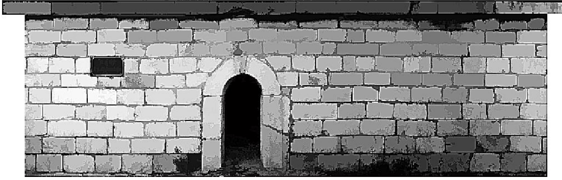
Şekil 8. Morfolojik İşlemler Sonucunda Oluşan Görüntü Üzerinden Unsharp Filtresi Geçirilmiş Hali
