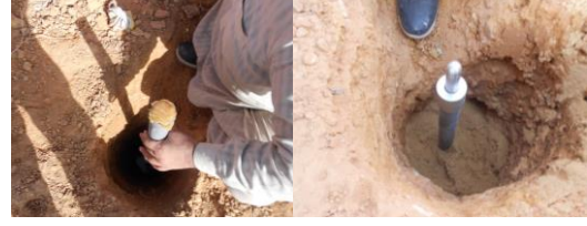
Şekil 6(a,b). PVC borunun gres yağı ile doldurulması ve kapatılması
