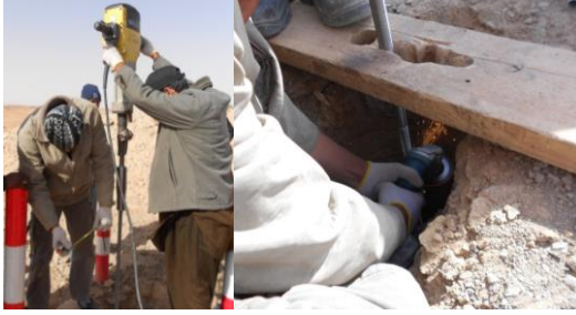
Şekil 4(a,b). Nivelman nokta çubuğunun çakılması ve sonlandırılması
