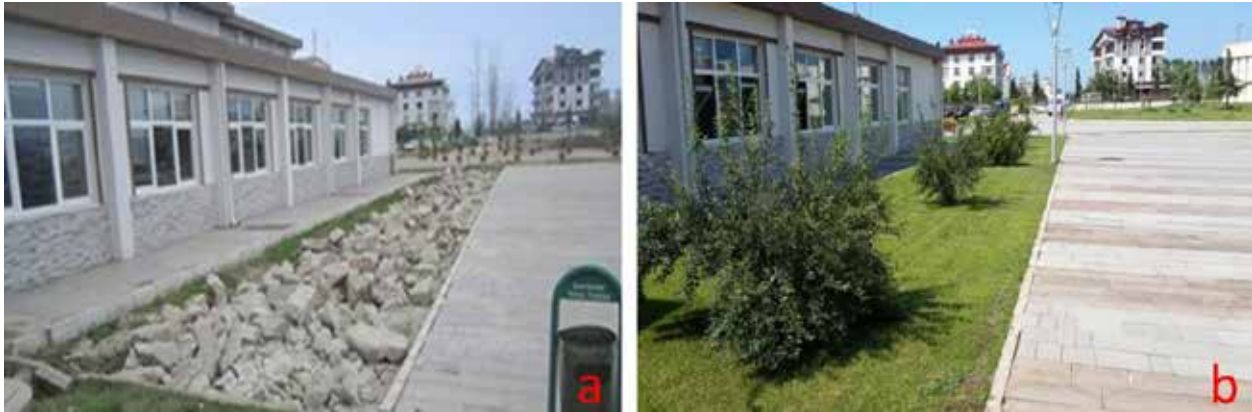
Şekil 14. Rektörlük binası çevresi (a-eski hali, b-son hali)
