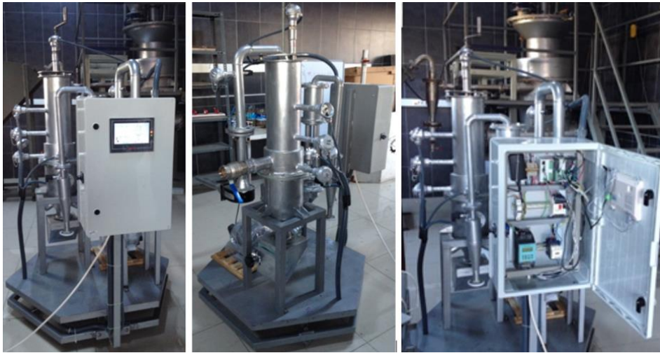
Şekil 1. Sistemde kullanılan ölçüm ve kontrol sisteminin reaktör üzerindeki görünümü
