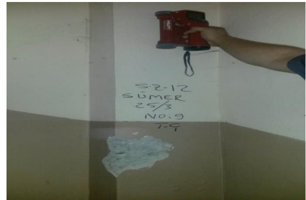
Şekil 2. Okuma yöntemiyle mevcut donatı tespiti
