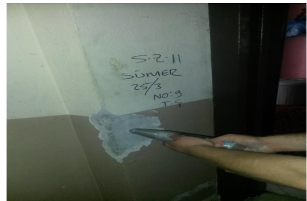
Şekil 3. Tahribatsız yöntemle beton dayanımının ölçülmesi
