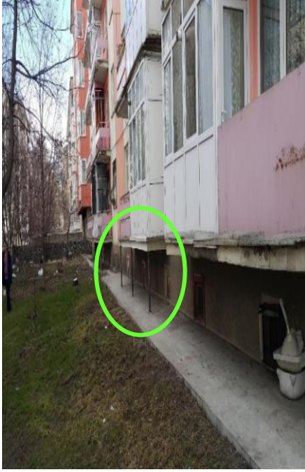
Şekil 5. Düşeyde yer yer çelik profillerle desteklenmiş balkon uygulaması
