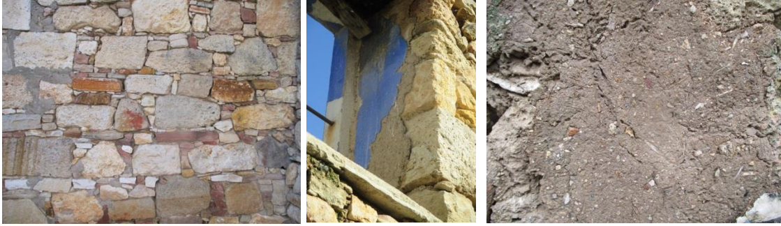
Şekil 15. Taş duvar ve sıva detayı
