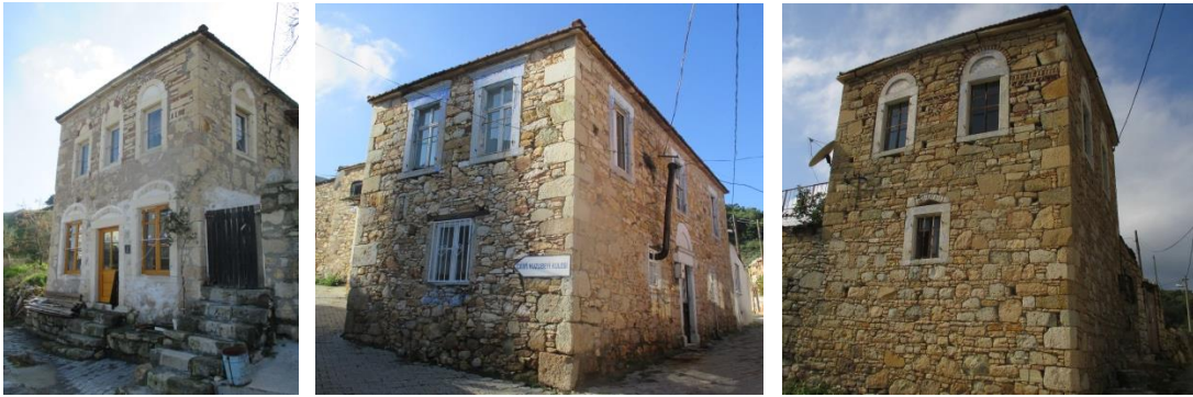
Şekil 8. Farklı boyutlardaki cephe açıklıkları
