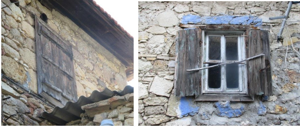
Şekil 6. Isı konforu sağlayan ahşap kepenkler
