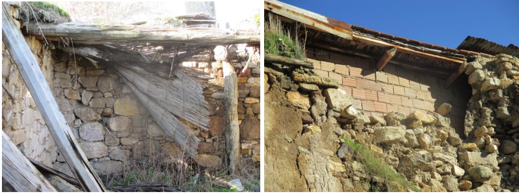
Şekil 16. Çatıda kargı kullanımı
