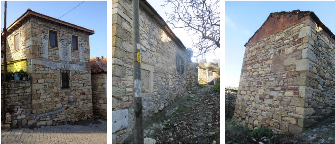
Şekil 7. Özgün boyutu değiştirilen veya tamamen kapatılan açıklıklar
