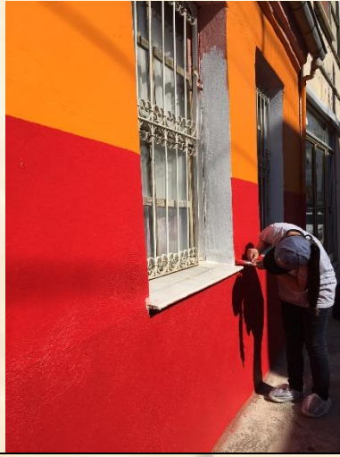
Fotoğraf 5: 50 No'lu yapı yüzey renklendirme uygulaması.
