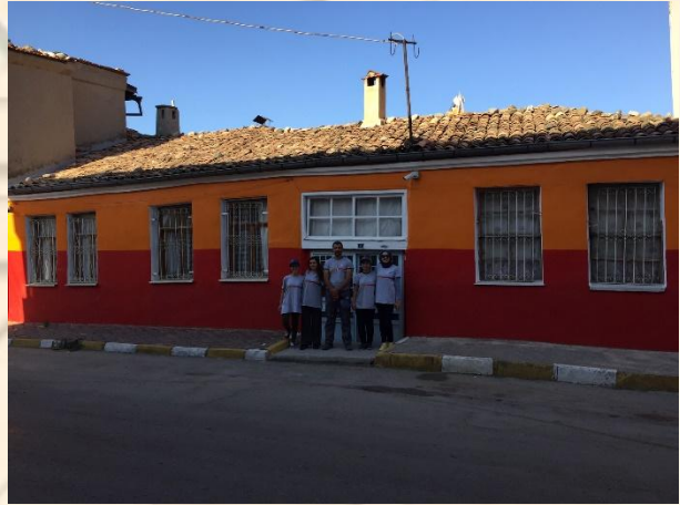
Fotoğraf 8: 50 No'lu yapı yüzey renklendirme uygulaması.
