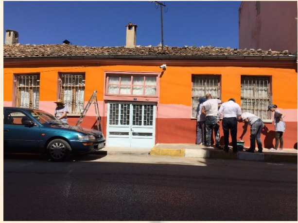
Fotoğraf 6: 50 No'lu yapı yüzey renklendirme uygulaması.
