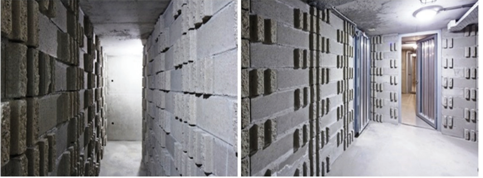
Şekil 3.3 - LEED platin sertifikalı bina bodrum katının labirent sistemi görünümü
