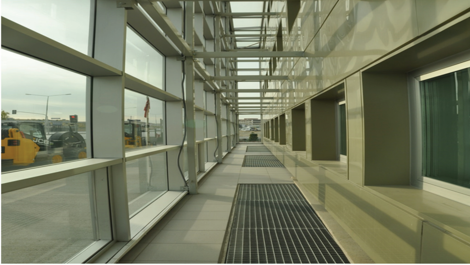
Şekil 3.1 - LEED altın sertifikalı binada trombe duvarı görünümü
