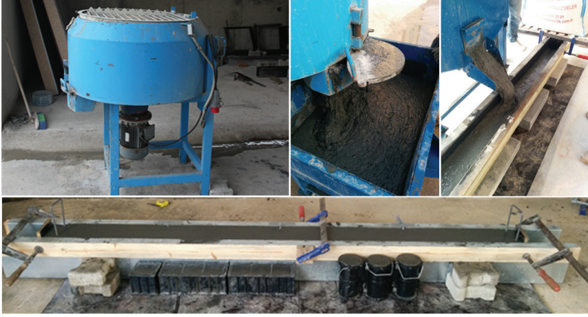
Şekil 3 - UYDB'nun Hazırlanması ve Kalıplara Yerleştirilmesi Aşamaları
