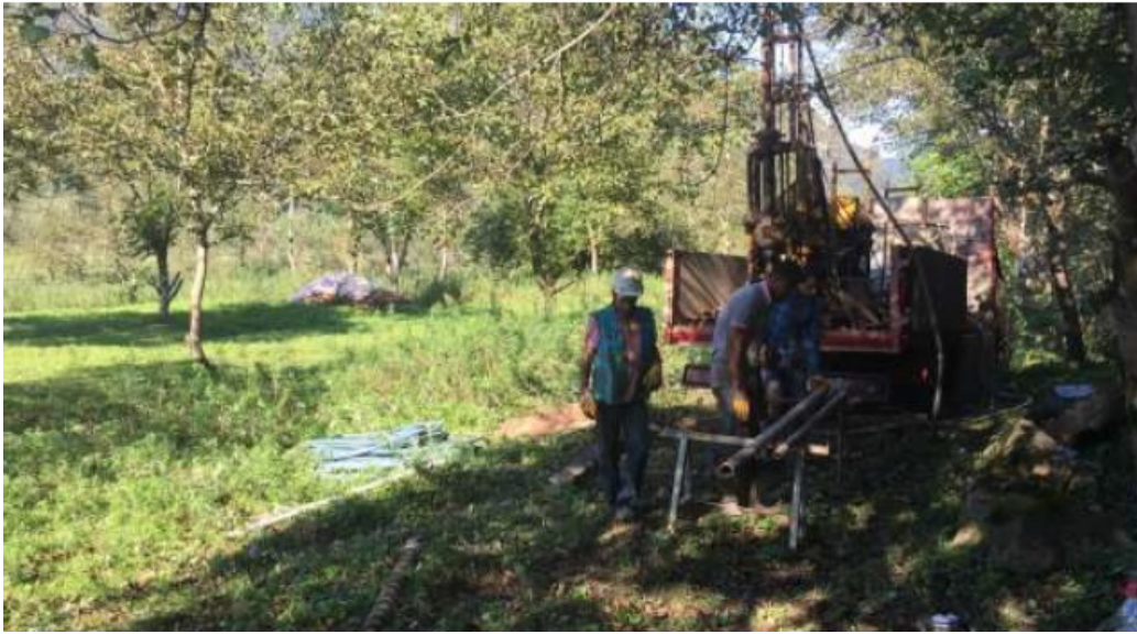
Şekil 3. Heyelanın topuk bölgesi yakınlarında gerçekleştirilen sondaj çalışması
