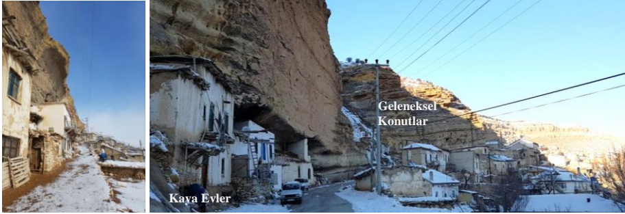
Resim 4. Taşkale Köyüne Giriş, Köy Yerleşimi ve Konutlar
