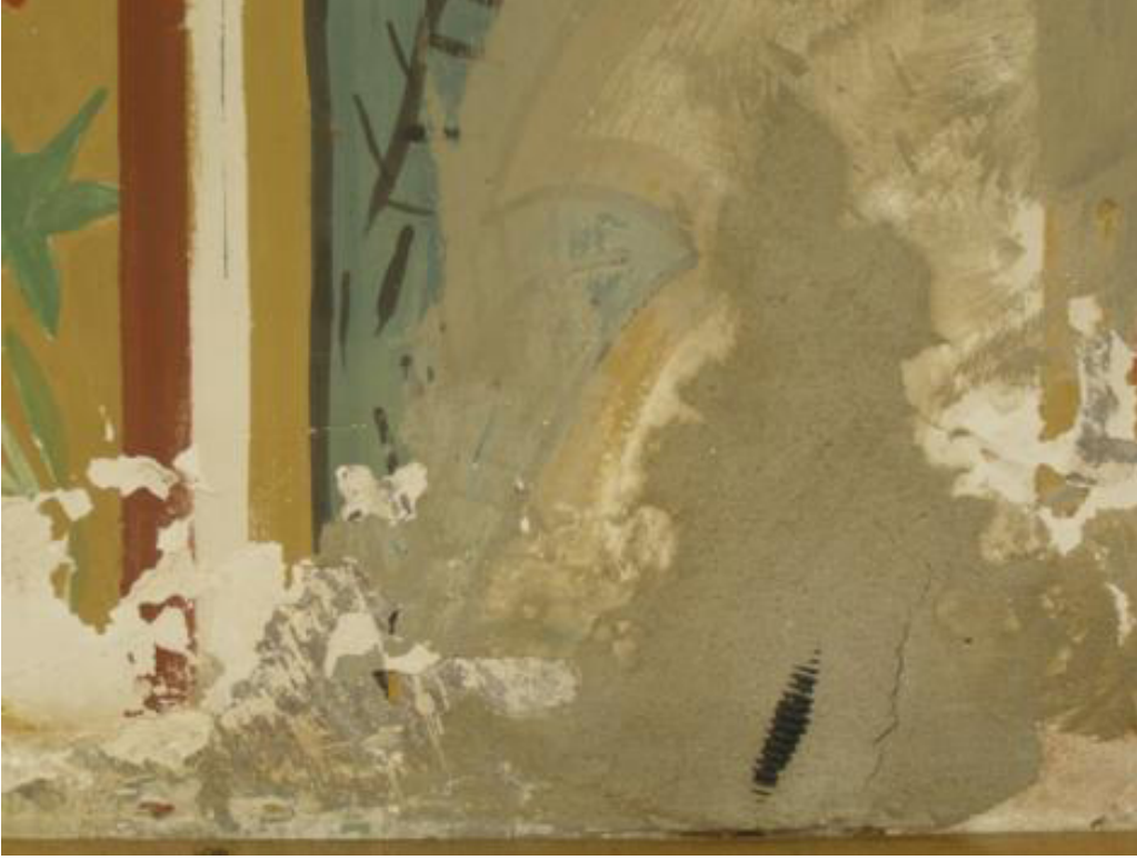
Resim 20. Tesisat Yenilemelerinden Bir Detay (E, Yetiş, 2015).
