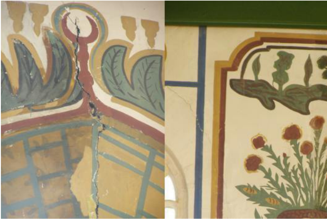
Resim 14. Resim Yüzeylerindeki Yarık Ve Çatlak Örnekleri (E. Yetiş, 2015).
