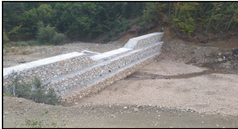
Fotoğraf 12. Çatağın deresinin ağız kısmına yaklaşık olarak 500 m. kala inşa edilmiş tersib bendinden bir görünüm.
