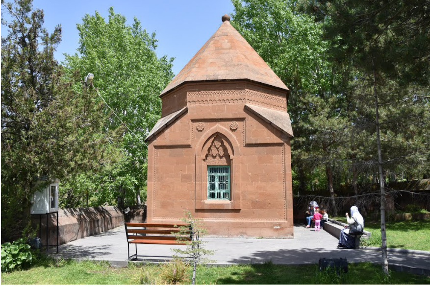
Resim 2: Türbenin bahçe içerisinde bir görüntüsü
