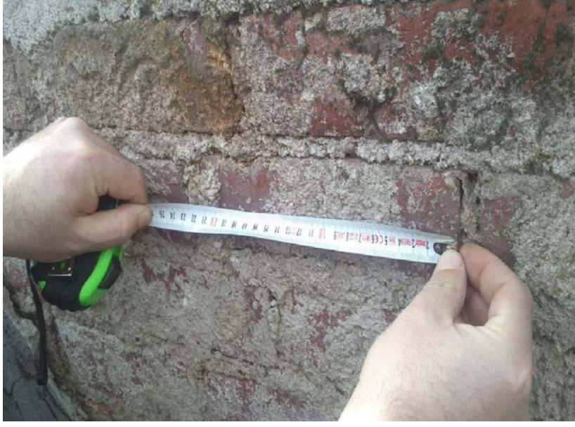
Şekil 4. İncelenen binada taşıyıcı duvar tespiti. 7. Determination of load-bearing wall in the masonry building.
