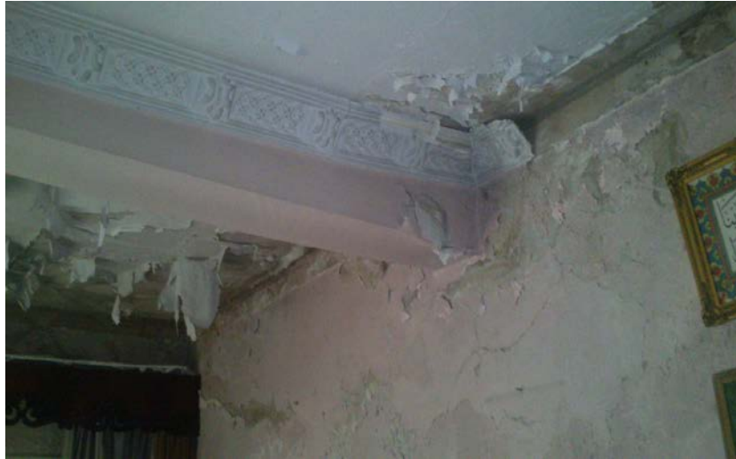
Şekil 3. İncelenen yapının betonarme tavan görünümü.
