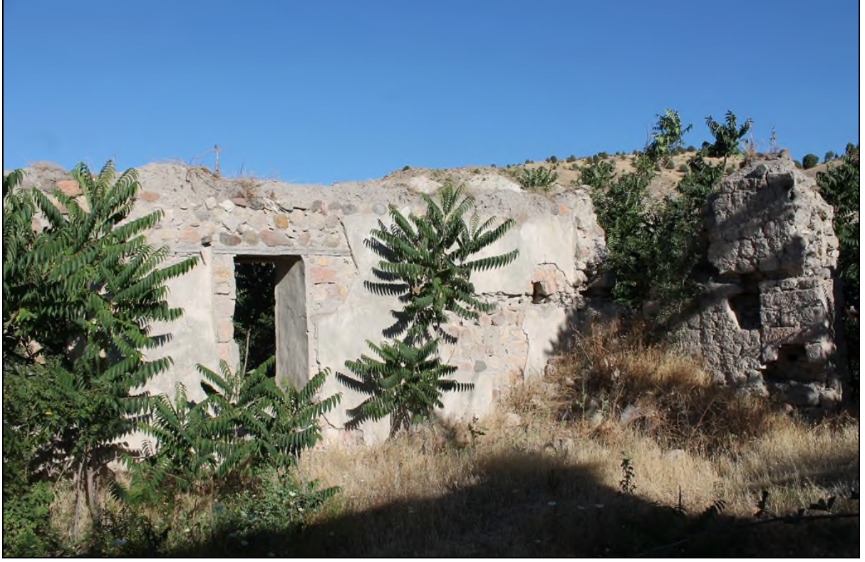
Resim 5. Derbentçik Camii batı duvarı içten görünüm fotoğrafı (2016).
