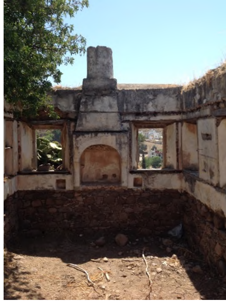
Resim 4: Doğu kısa duvarı ve ocak yapısı
