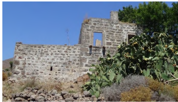
Resim 2: Evin doęu kısa duvarı dıř cephesi
