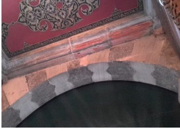
Şekil 26. Bursa Yeşil Cami kuzey cephesi cümle kapısı yay kemerinde iki renkli taş uygulaması (Gök arşivi 2017)
