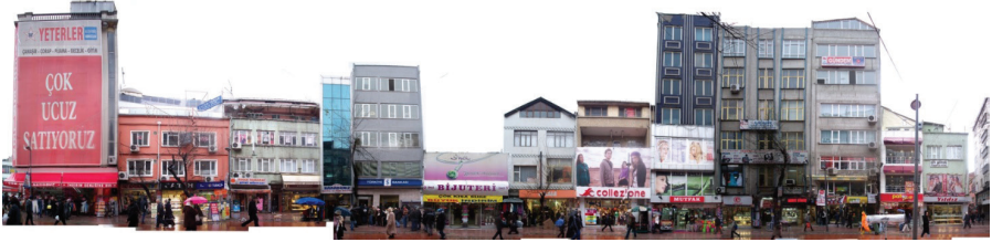
Şekil 9. Bağlarbaşı Caddesi Sol Cephe.
