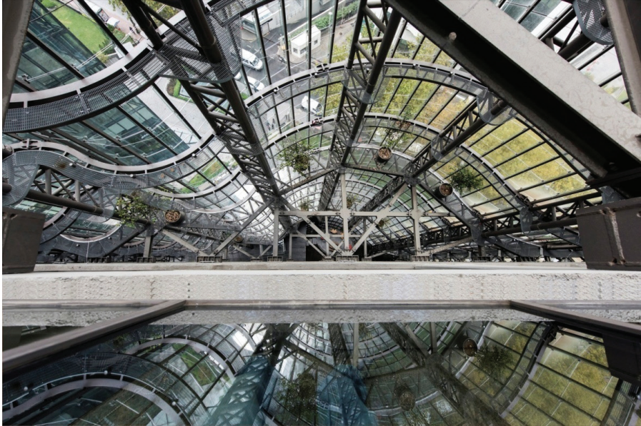
Şekil 11. Bina Yüksekliğinde Çift Kabuk Cephe Örneği Maslak no:1 ofis binası [25]
