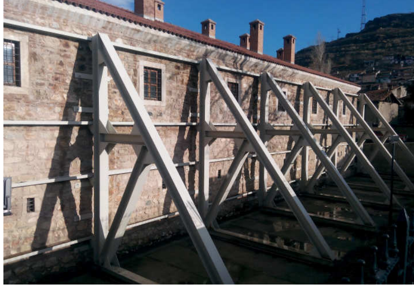
Resim 3. Yapıda uygulanan çelik payanda sistemi.
