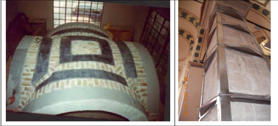
Resim 1. Tarihi yapıların karbon fiber ve çelik ile güçlendirilmesi.
