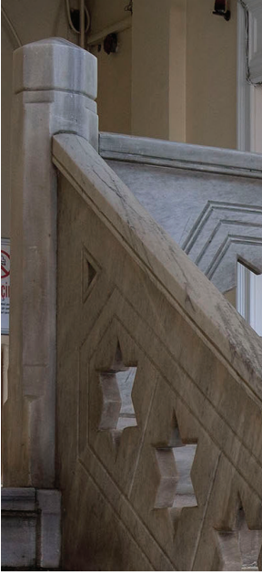
Fot. 3: Posta ve Telgraf Nezareti Binası merdivenlerinden detay. (Cemal Emden, 2015.)
