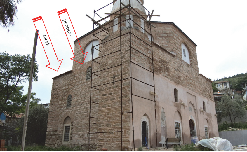
Fot. 33: Gölarmara Şahuban Camii'nde pencere-saçak ve duvar-kasnak ilişkisi.
