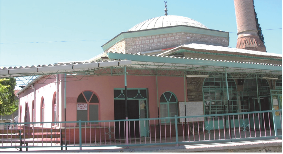
Fot. 5: Doğu cephedeki ek yapı.
