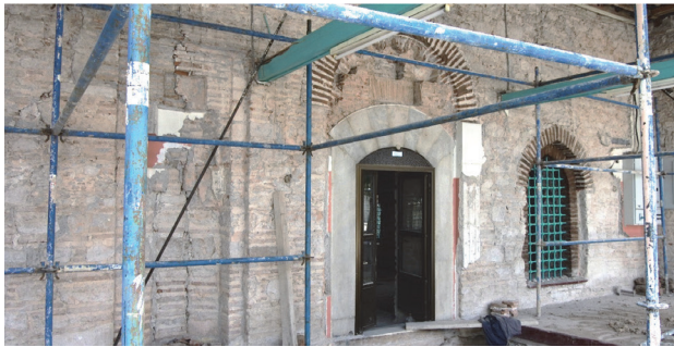
Fot. 10: Kuzey cephe.
