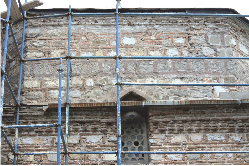
Fot. 32: Kasnağın duvar örgüsü ve güneş kursları.
