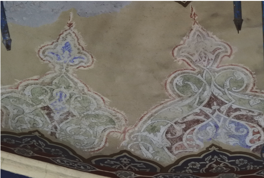
Fot. 27: Kubbe eteği; raspa sonrasında ortaya çıkan, iki ayrı süsleme dönemine ait izler.
