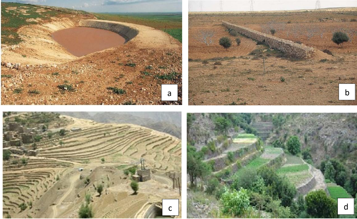
Şekil 5. Vadi Tabanı Sistemleri (Ekinci, 2015), a) Suriye'deki küçük çiftlik göleti (Ekinci,2015), b) Mısır'ın kuzeybatısındaki vadi tabanı taş duvarları (Ekinci,2015), c,d) Yemen'de bulunan teras sistemleri
