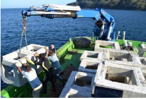
Şekil 10. Beton blokların denize atılması
