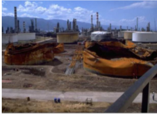
Şekil 4. Tüpraş rafinerisinde meydana gelen yangın hasarı(Erdik, 2000)
