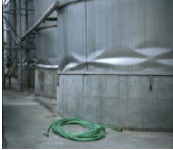
Şekil 3. Elmas şekli burkulması
