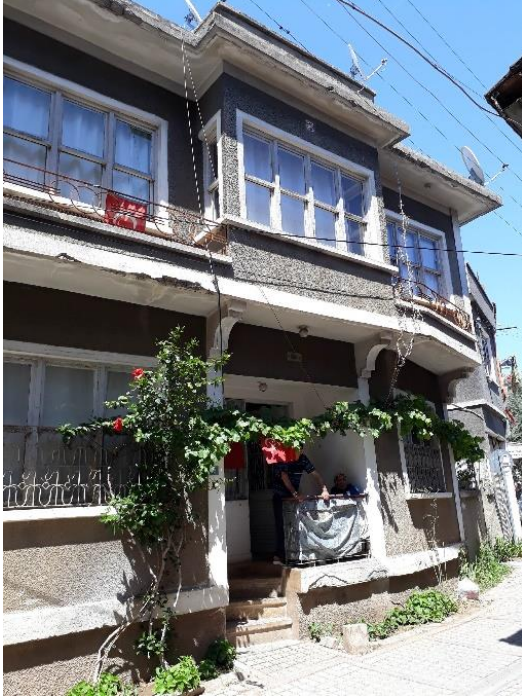
Resim 3. 422. Sokak 15 kapı numaralı konutun giriş cephesi (Kadir Emre Bakır arşivi).
