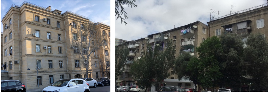
Görsel 11. Nizami Sk.-1955 (Solda)
