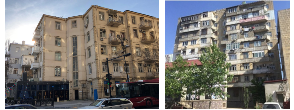
Görsel 15. Nizami Sk.-1965 (Solda)
