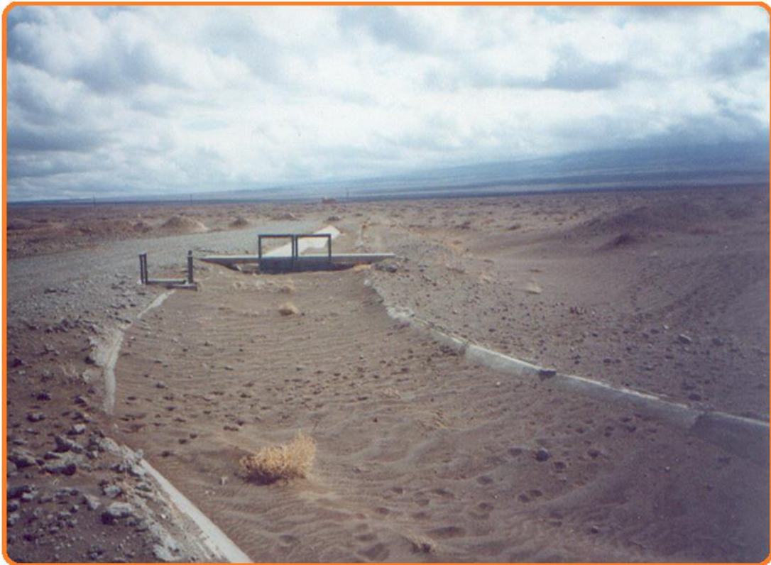
Şekil 6. Sulama yapılarında sediment birikimi
