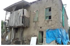
Şekil 12. Ahşaptan yapılan ve sonradan ilave edilen banyo ve tuvalet
