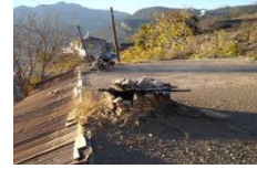
Şekil 24. Damda inşa edilmiş baca
