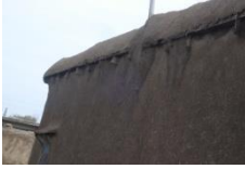
Şekil 28. Yetersiz saçak çıkmaları ve hasara uğramış sıvalar
