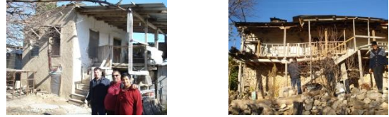
Şekil 5. Güney cephe avlular
