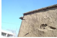
Şekil 28. Yetersiz saçak çıkmaları ve hasara uğramış sıvalar
