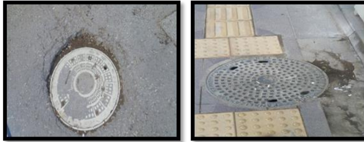
Şekil 19. Necip Fazıl Kısakürek Sokağı üzerinde yer alan alt yapı tesisleri bakım kapakları
