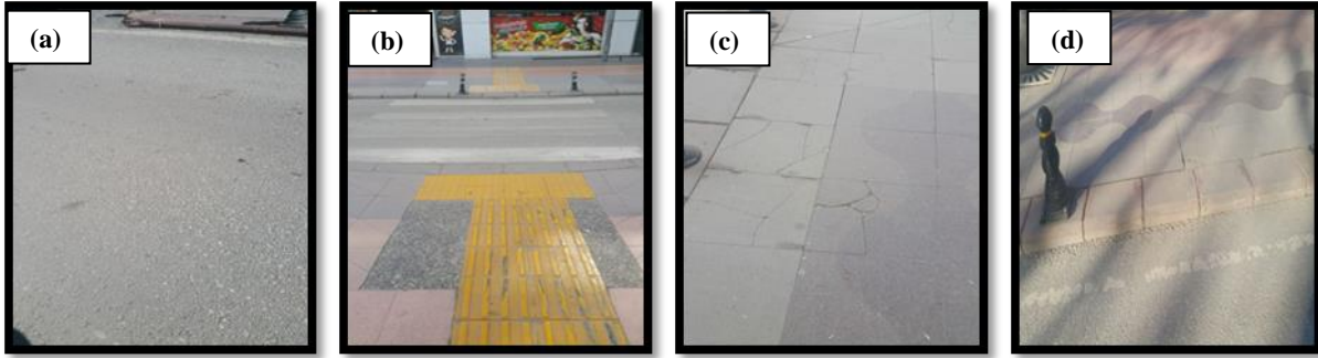
Şekil 3. Necip Fazıl Kısakürek Sokağı araç yolu-asfalt (a), yaya geçiti-waschbeton (b), kaldırım-beton plak taş (c) ve bordür-beton (d)
