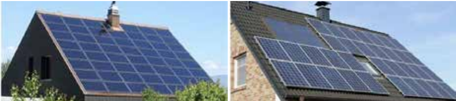
Şekil 4.1: Çatılarda fotovoltaik panel uygulamaları [19].
