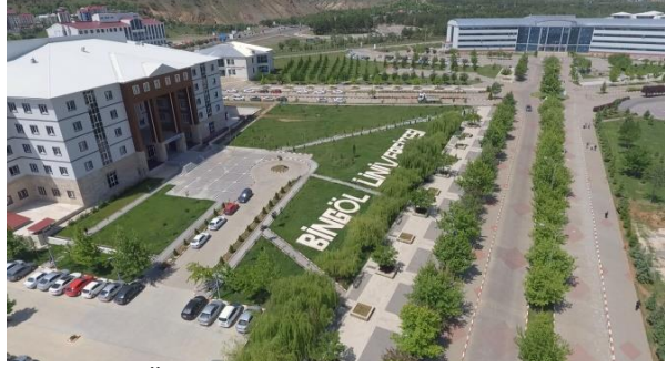
2.2. B.Ü. Rektörlük binası ve ana aksı (Url 1)
