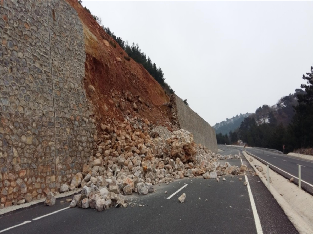
Foto 4: Yama dengesinin bozulması sonucunda byk miktarda malzeme istinat duvarını yıkarak yola tařmıřtır. Bitki rtsnn tahrip edilmesi de bunda nemli rol oynamaktadır (Balıkesir – Edremit Karayolu 60. Km, 2015).
