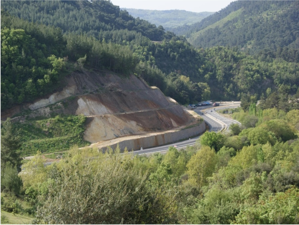
Foto 5: Balıkesir – Edremit Karayolu 62. km’sinde yamaç dengesini korumak amacıyla yapılan teraslamanın görünümü (2015).
