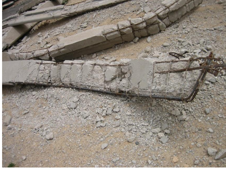
Şekil 11. Aşık kiriş donatı detayı
