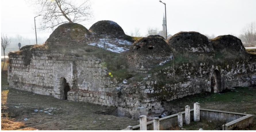
Şekil 8. Mihalbey hamamı kuzeydođu köşesi görünüş
