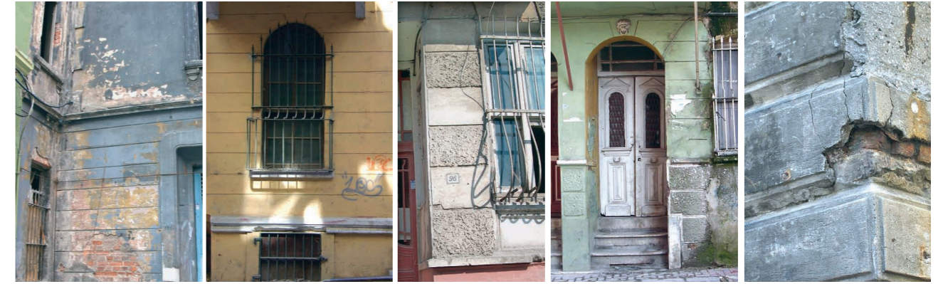
Şekil 6. Kesmetaş ve köşetaşı taklitleri (soldan sağa): Apts. Castorides (Beyoğlu Yeşilçam Sokak 27), apartman (Galata Serdar-ı Ekrem Sokak 26, 1905'ten önce), konut (Balat Vodinya Caddesi 96, 20. yy. başı), konut (Balat Hızırcauş Köprüsü Sokak 2, 20. yy. başı) ve Marmara Han (Beyoğlu Kurabiye Sokak 1, 1893).
