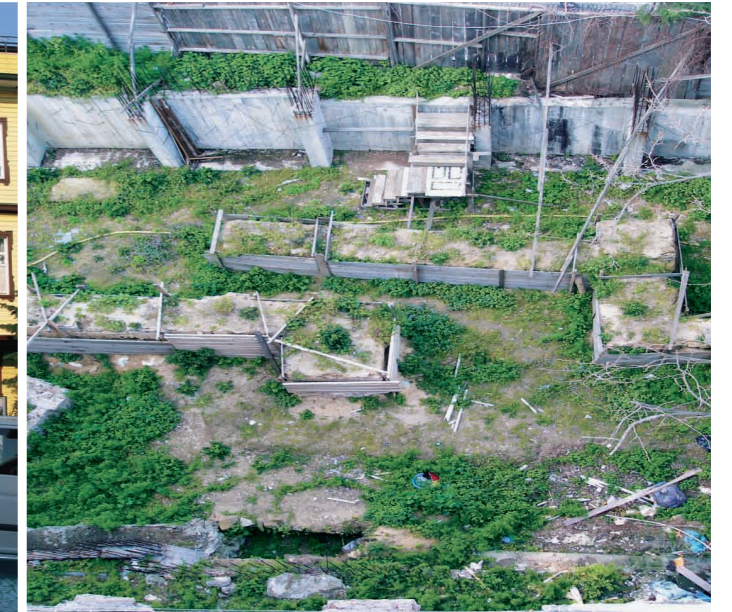
Resim 2: Obelisk Oteli Yapı Temel Kalıntıları
