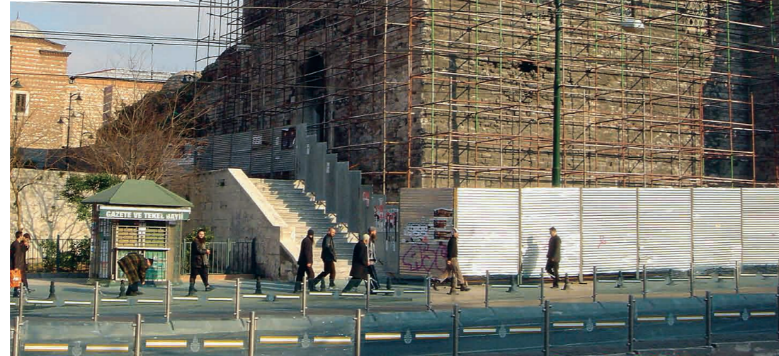
Resim 8: İstanbul, Laleli II. Beyazıt Hamamı (Patronuhalil Hamamı) restorasyonu.
