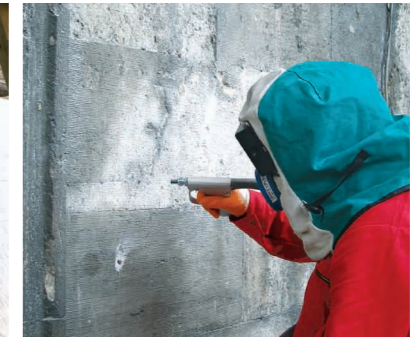
F.16: Kontrollü mikro kumlama ile yüzey temizliği (A.Gülec, 2007)
