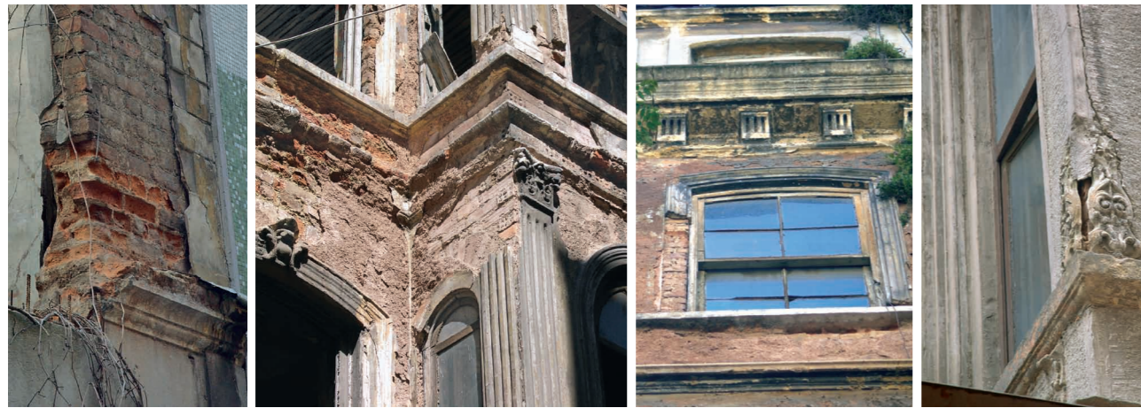
Şekil 4. Kargir duvar üzerinde uygulanmış yapay taşlar (soldan sağa): konut (Beyoğlu Kilit Sokak 3), konut (Beyoğlu Kilit Sokak 1), apartman (Galata Serdar-ı Ekrem Sokak 26, 1905'ten önce) ve konut (Beyoğlu Ögüt Sokak 11, 1905'ten önce)
