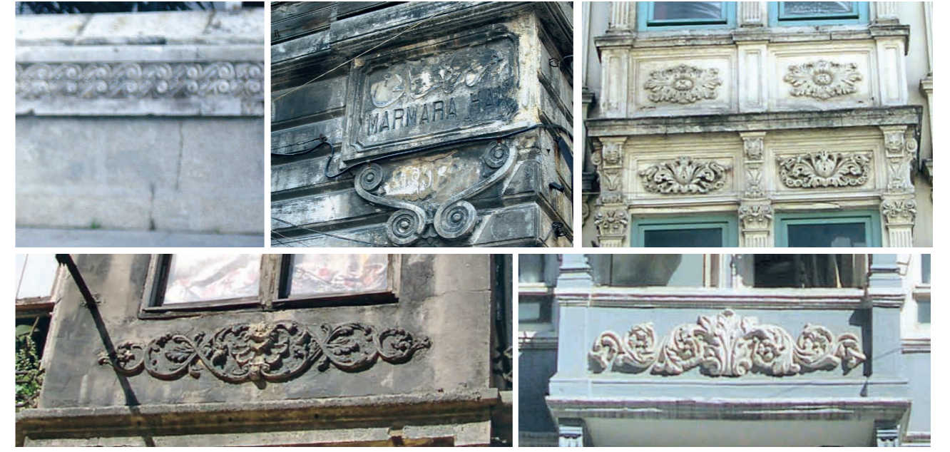
Şekil 14. Yapay taş bezeme örnekleri (soldan sağa): (üst sıra) bezeme örgesi, Hıdıva Sarayı bahçe duvarı (Bebek, düzenleme A. Lasciac, 1900-1901), isim levhası, Marmara Han (Beyoğlu Kurabiye Sokak 1, 1893), pencere altı ve üstünde bezeme levhaları, Apparts. Couteau (Beyoğlu İstiklal Caddesi 135, 1905'ten önce), (alt sıra) apartman (Beyoğlu Sakızağacı Caddesi 5, 1905'ten önce) ve apartman (Beyoğlu İstiklal Caddesi 52, 1874).
