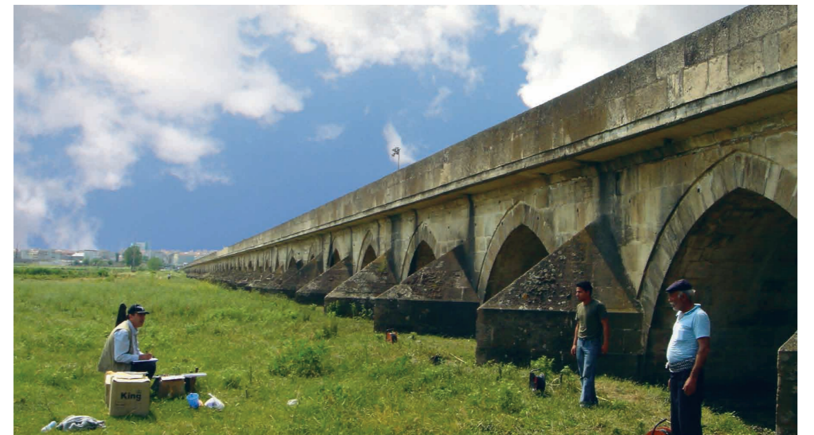
Resim 4: Edirne Uzunköprü ilçesi Uzunköprü ayaklarında Jeofizik (Jeoelektrik) ölçmeler.
