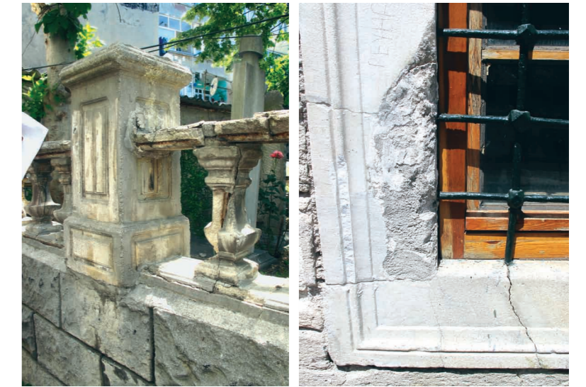
F.18: Uygun olmayan bütünleme ve imitasyon uygulamalarından örnekler (KUDEB Proje Grubu, 2009)
