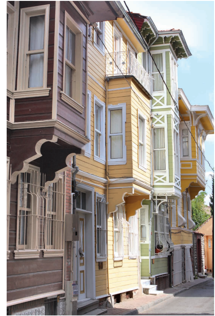
İBB-KUDEB tarafından onarımı gerçekleştirilen ahşap bina onarımına örnek bir sokak uygulaması (Parmaklık Sokak, Zeyrek)
