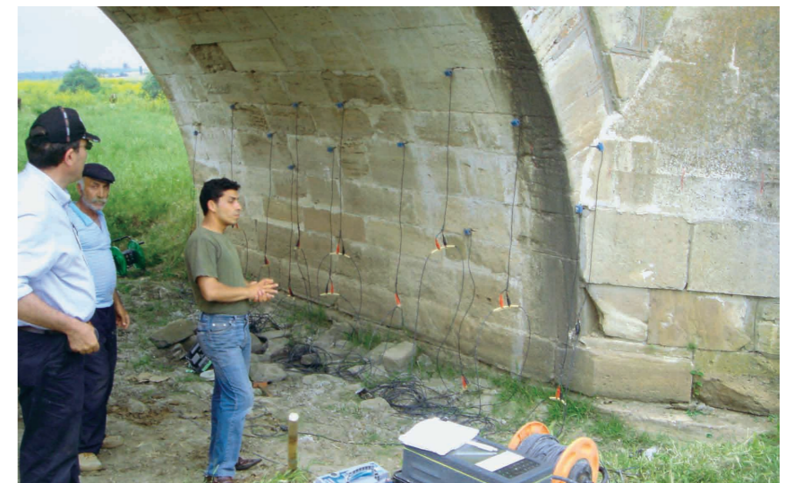
Resim 11: Edirne, Uzunköprü ilçesi Uzunköprü Kemerli yan duvarında yapılan sismik etüt
