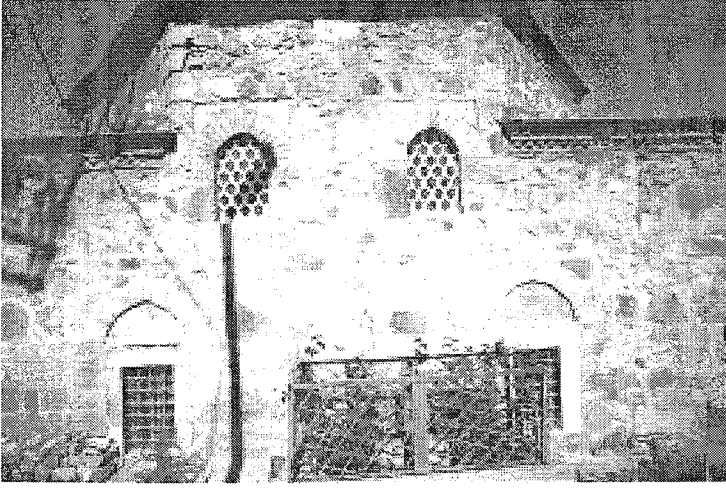
Fotoğraf 3. Alaca Minare Mescidi, güney cephe pencere düzenlemesi
