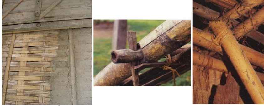
Şekil 11. Bambu Örgü Döşeme ve Birleşim Detayları (Subhankar ve Amol, 2013)
