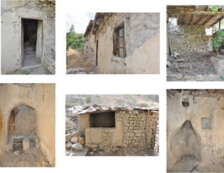
Foto. 11: Tanasur Deresi'nde Terk Edilmiş Evler ve Mekan Düzenlemeleri
