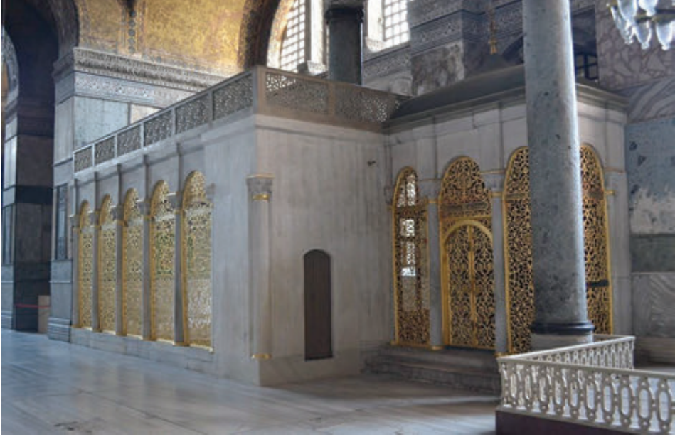
Foto. 1: Kütüphanenin Ayasofya İç Mekanında Kalan Giriş Cephesi.
