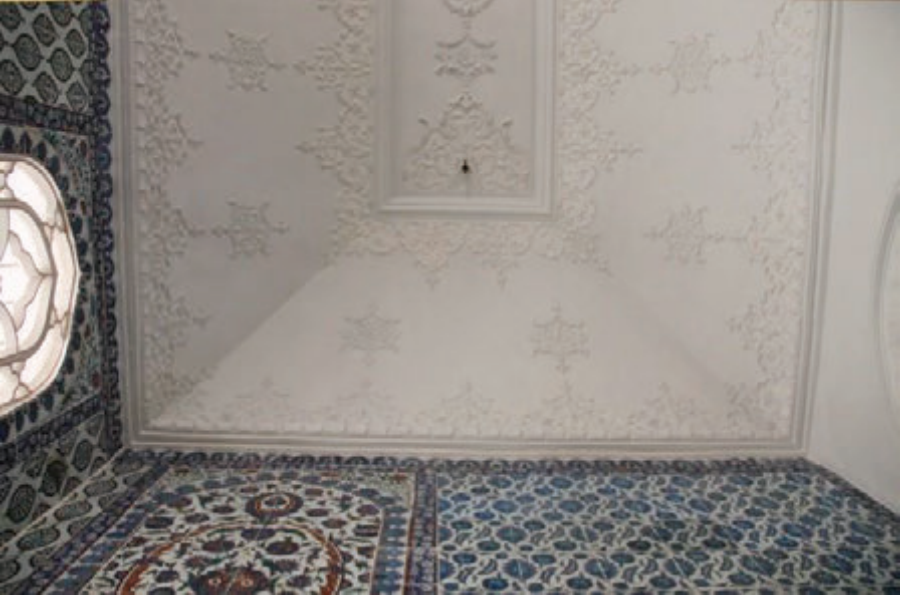
Foto. 23: Restorasyon Sonrası Hazine-İ Kütüb Bölümü Tonzunun Malakarilerinin Tamamlanmış Hali.
