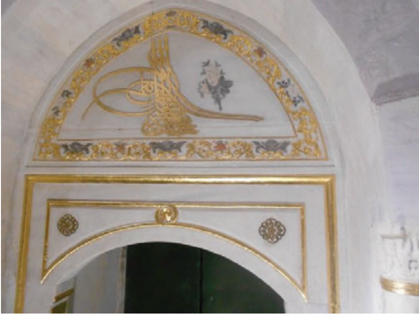
Foto. 25: Restorasyon Sonrası Hazine-İ Kütüb Bölümünün Kapısı Mermer Temizliği Ve I.Mahmud Tuğrası Ve Çevresin Altın Varak Yapılmasının Ardından Durumu.
