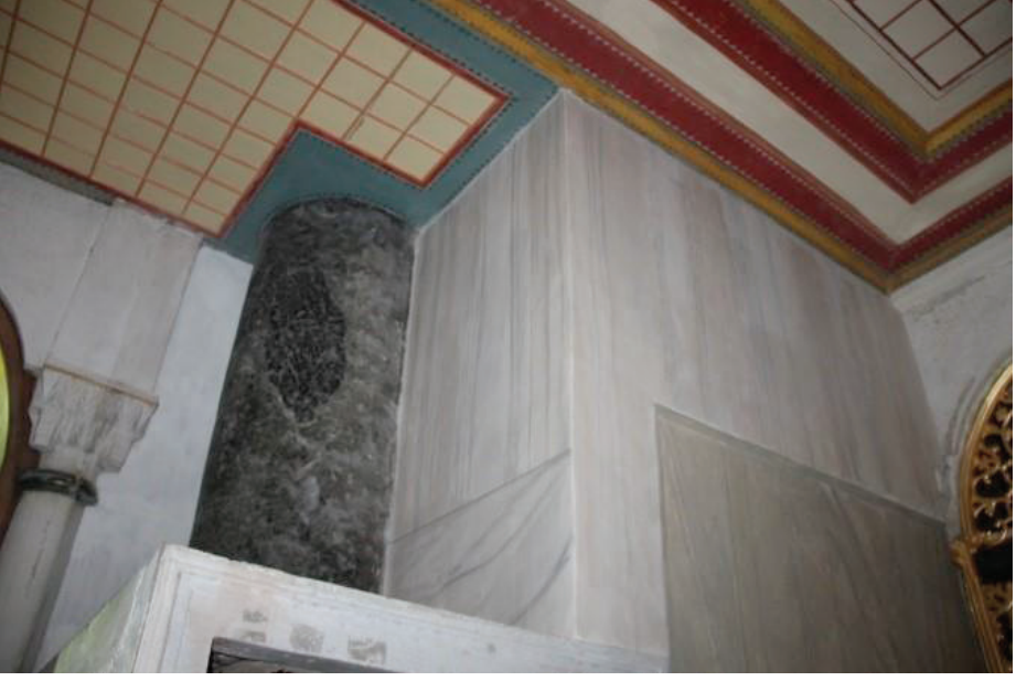
Foto 15: Restorasyon Sonrası Muhdes Kısımın Alınmasından Sonra Özgün Ayasofya Sütunu Ve Duvar Yüzeyinin Açığa Çıkmış Hali.
