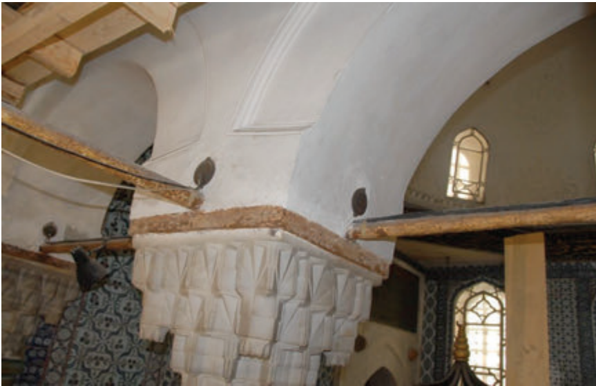
Foto. 26: Restorasyon Öncesi Hazine-İ Kütübde Bulunan Metal Elemanlarının Durumu
