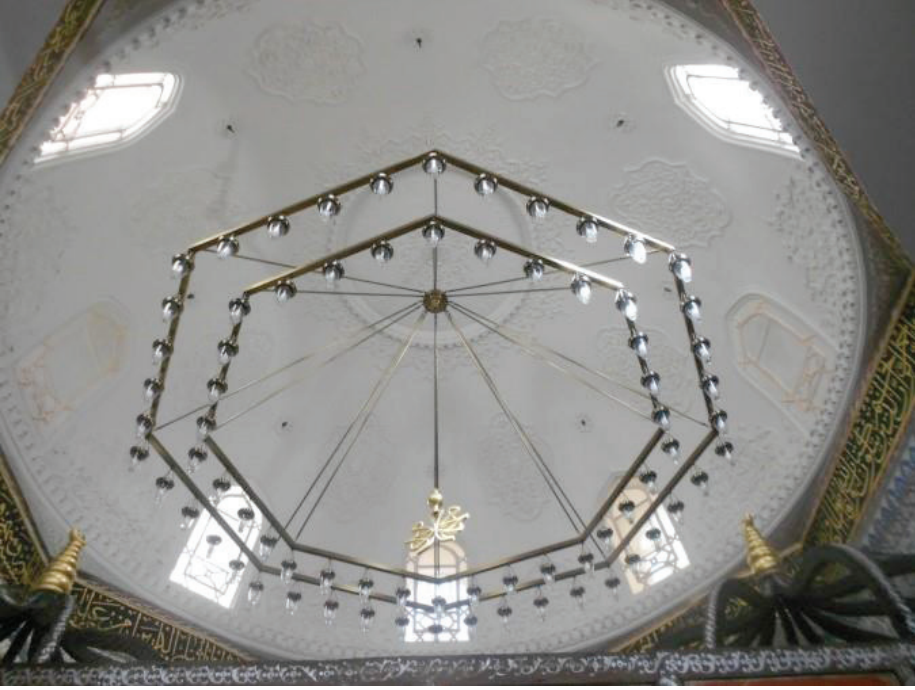
Foto 21: Restorasyon Sonrası Hazine-İ Kütüb Bölümü Kubbesi
