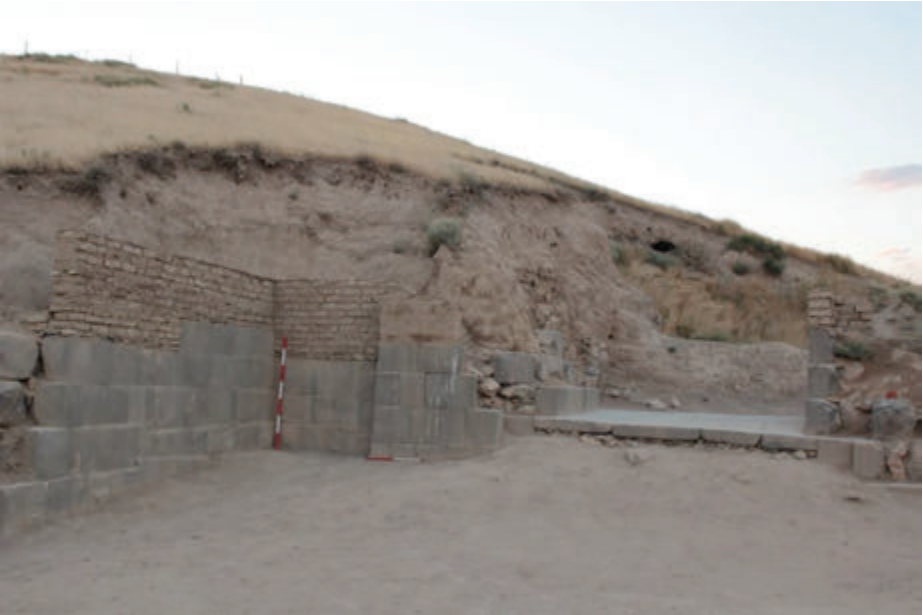
Foto. 2: Güney Sur-Anıtsal Kapı Koruma-Onarım Çalışmalarından Sonraki Hali
