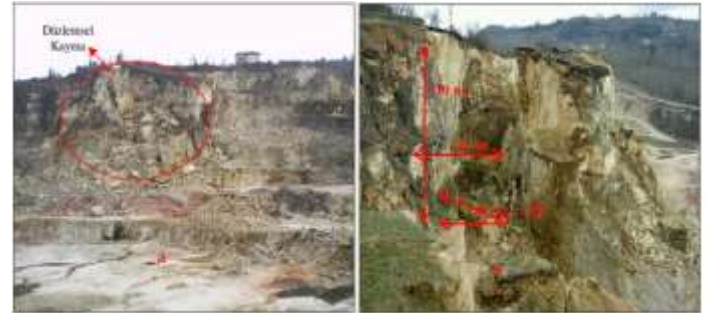
Şekil 3. Şevlerin kayma oluştuktan sonraki (a) ve yakından görünümü (b) (Erçikdi ve ark., 2006)
